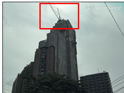
ภาพที่ 63 ควบคุมแขนบูมของเครนให้อยู่ในพื้นที่ก่อสร้าง
