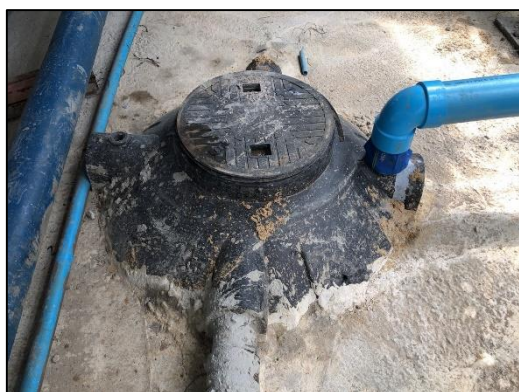
ภาพที่ 35 ถังบำบัดน้ำเสียสำเร็จรูป
