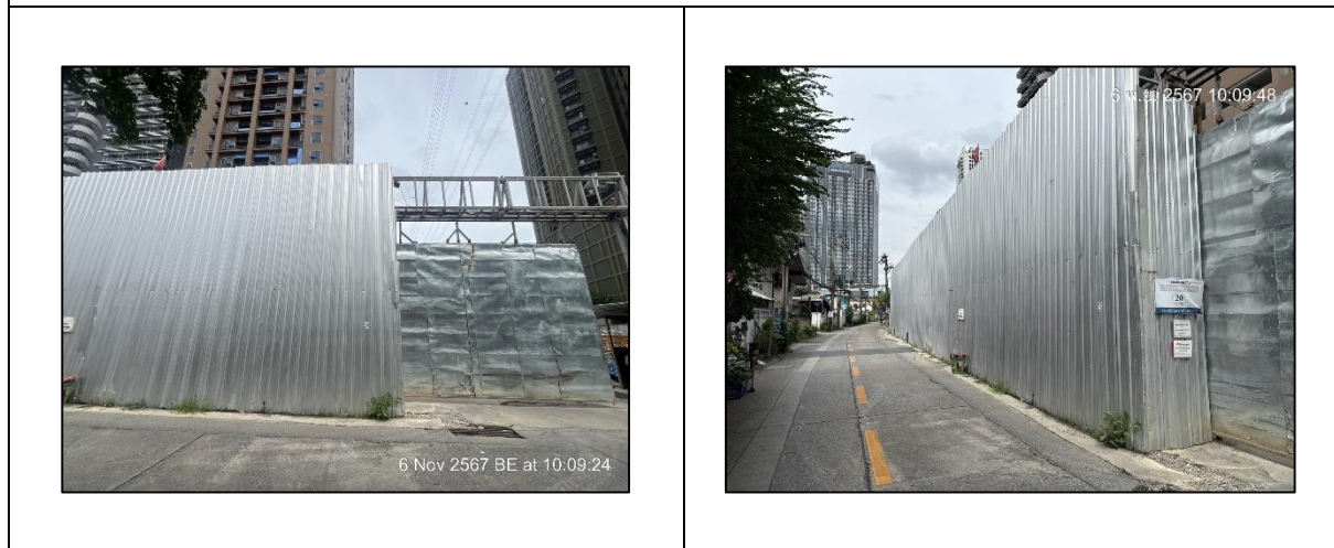
ภาพที่ 2 รั้ว Metal Sheet สูง 6 เมตร
