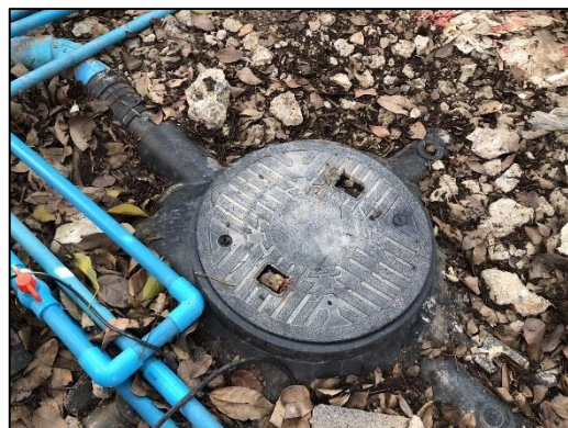
ภาพที่ 62 ถังบำบัดน้ำเสียสำเร็จรูปบริเวณบ้านพักคนงาน
